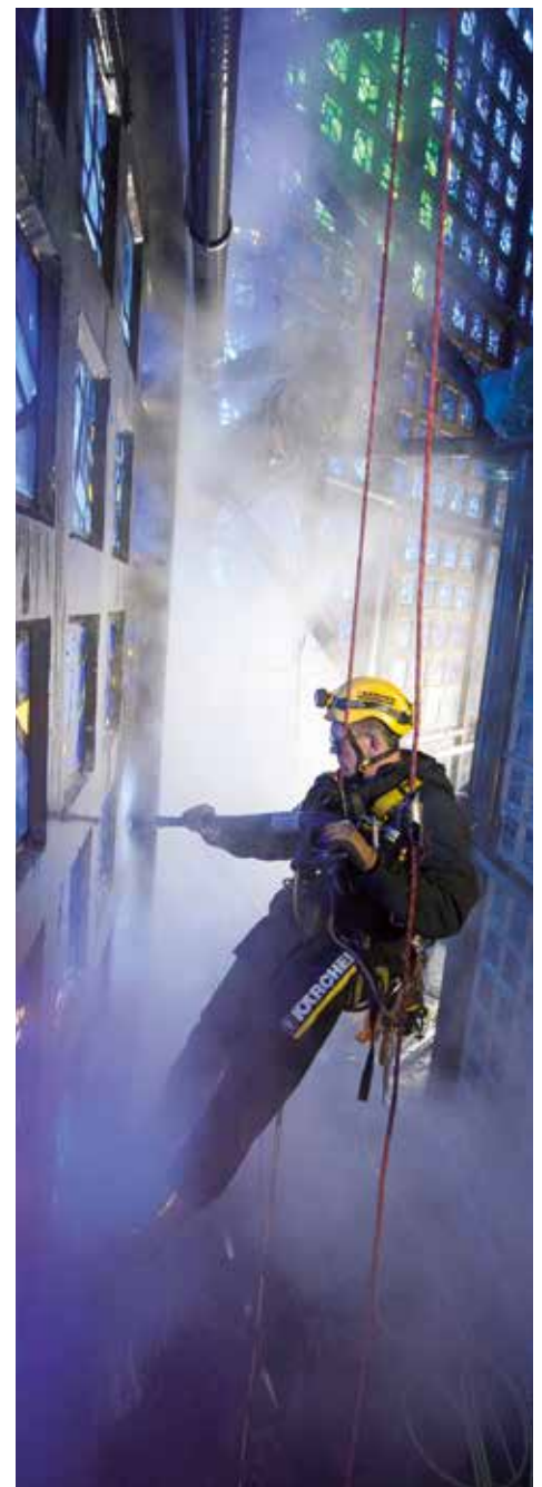
16.200 Fensterelemente wurden vom 50 Jahre alten Schmutz befreit.
